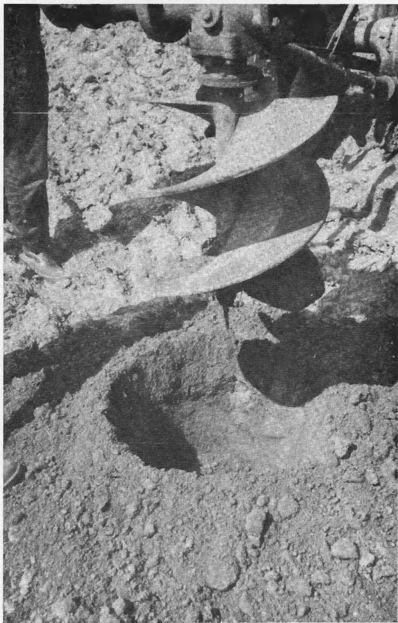
Foto 8 — Abertura da cova, utilizando a broca mecânica, a fim de romper a camada endurecida existente na superfície do solo.
